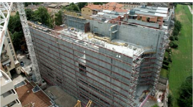
Museion, Bolzano/Italie Étanchéité du sous-sol Fin des travaux : 2005
