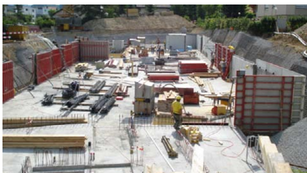
Lindenhof, Abtwil/Suisse, immeuble d'habitation Étanchéité d'un parking souterrain, dalle haute comprise Fin des travaux : 2010
