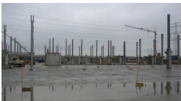
Gerasdorf/Autriche, centre commercial Étanchéité d'un parking souterrain, dalle haute comprise Fin des travaux : 2010
