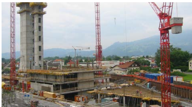
Hôtel Sheraton Dornbirn/Autriche Étanchéité du sous-sol Fin des travaux : 2004
