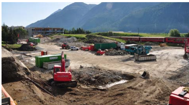
Projet d'urbanisation Pro Vivaint, Samedan/Suisse, immeuble d'habitation Étanchéité d'un parking souterrain en projet Fin des travaux : 2012
