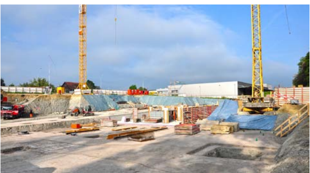
Projet Simishölzli, Arbon/Suisse, immeuble d'habitation Étanchéité d'un parking souterrain Fin des travaux : 2012
