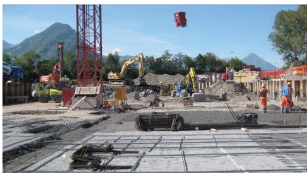
Aldi Interlaken/Suisse Étanchéité d'un parking souterrain Fin des travaux : 2010
