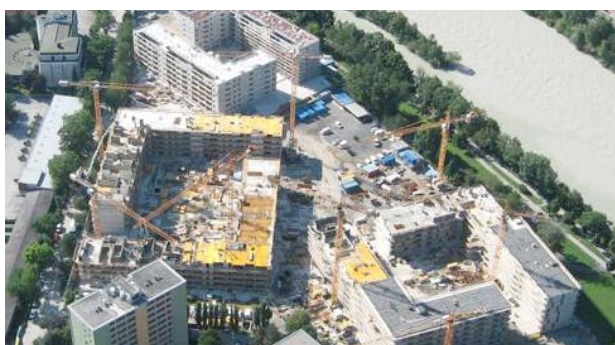
Projet d'urbanisation Tivoli, Innsbruck/Autriche Immeuble d'habitation et bâtiment à usage commercial Étanchéité d'un parking souterrain, dalle haute comprise Fin des travaux : 2008
