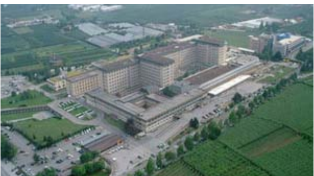
Clinique de Bolzano/Italie, bâtiment public Étanchéité du sous-sol Fin des travaux : 2012
